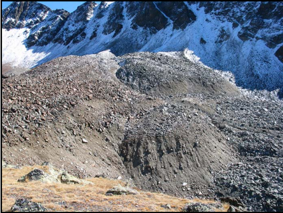
Abbildung 24: Ein kleiner Bereich des Blockgletschers "Im Kar" hat sich aufgrund einer Versteilung des Geländes im Untergrund abgesetzt ("Zwickel"). Rechts im Hintergrund der doppellappige "Eiskasten" Blockgletscher (siehe dazu Kapitel 5.3)
